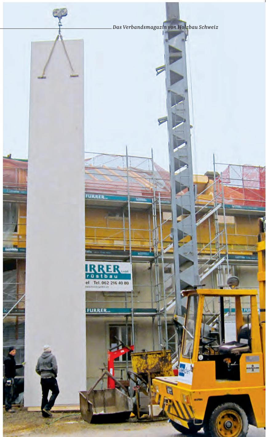
Die Seitenwand des viergeschossigen Liftschachts wird in ihrer gesamten Länge von oben per Kran ins Haus geschoben.
