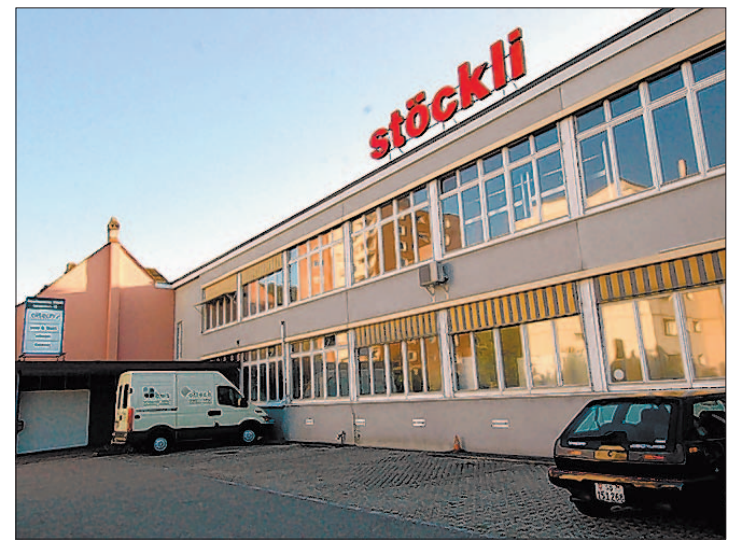
VERGANGENHEIT Die Liegenschaft ist wärmetechnisch saniert und der Stöckli-Schriftzug ging ans Historische Museum Olten. BKO
